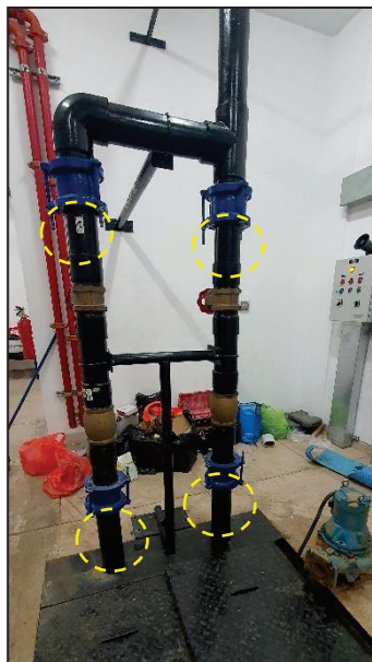
Instalación de abrazaderas debajo de uniones tipo dresser de 4"
