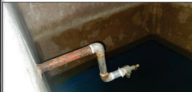
Reemplazar tubería oxidada que cruza hacia el interior de cisterna de agua para llenado de la misma
