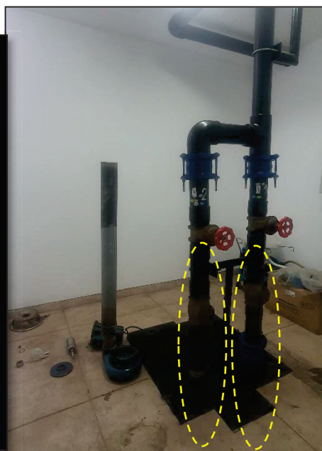
Cambio de tuberías y accesorios desde bombas sumergibles En el interior del pozo hasta las válvulas check.
