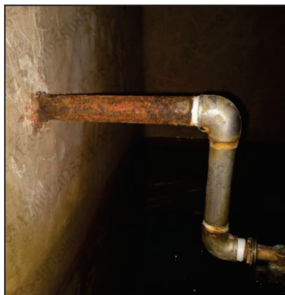
Reemplazar tubería oxidada que cruza hacia el interior de cisterna de agua para llenado de la misma
